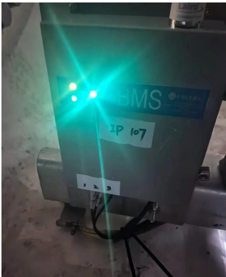
图 3.2 风机主机安装照片
